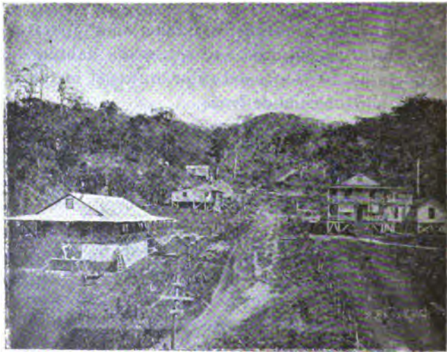
«Campamento» de la mina Tres Amigos
