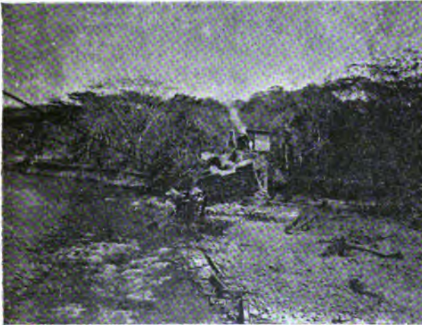
Paso del río Barranca
