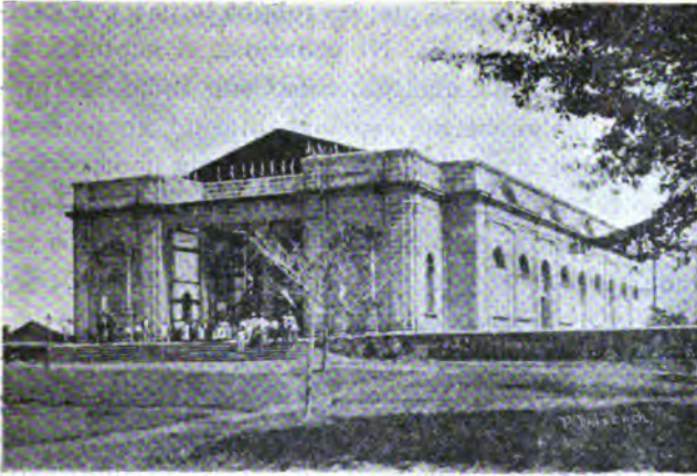
Palmares.—Iglesia en construcción
