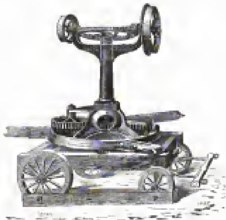
Fig. 232 — Moulin portable de M. Girard.
