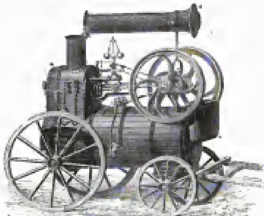
Fig. 140. — Moteur à vapeur portable de MM. Gardner & Soutter.
