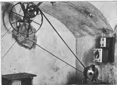
Fig. 10. Einphasiger Motor zum Betriebe von Hack- und Kettmaschinen.
