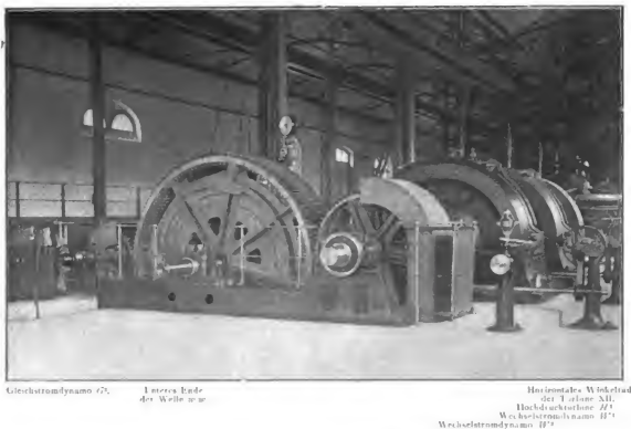
Wechselstromdynamo H 3
