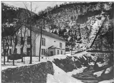
Fig. 5. Centrale des Elektrizitätswerks.
