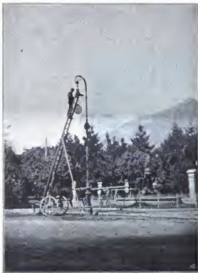
Fig. 6. Bedienung der Bogenlampen in Chur.
