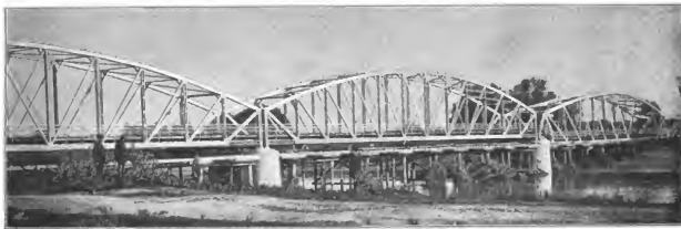
Fig. 1. Strassenbrücke über die Morawa bei Ljubitschewo (Serbien).
