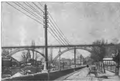
Fig. 7. Lufteleitung am Aare-Quai.
