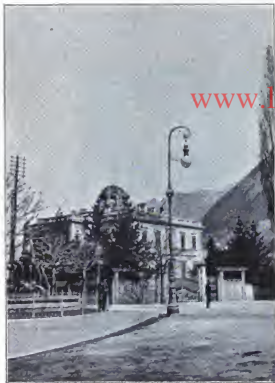
Fig. 4. Bogenlampen-Kandelaber mit Transformator.
