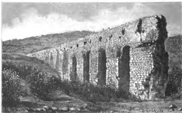
Wasserleitung im Wed Scherichera. (Nach einer Photographie.)
