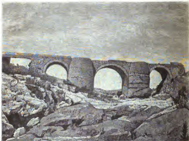
Wasserleitung in Sbeitla. (Nach einer Photographie.)
