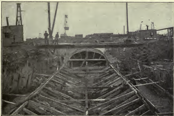
CONSTRUCTION OF A SEWER CONDUIT
