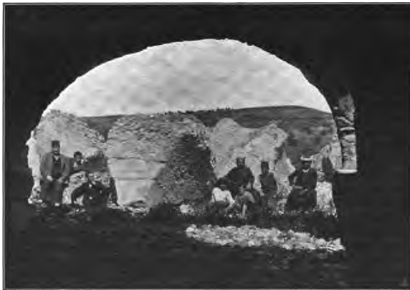
Fig. 10 Abgestürzter Zwickel der Cisterne auf Kösten.
