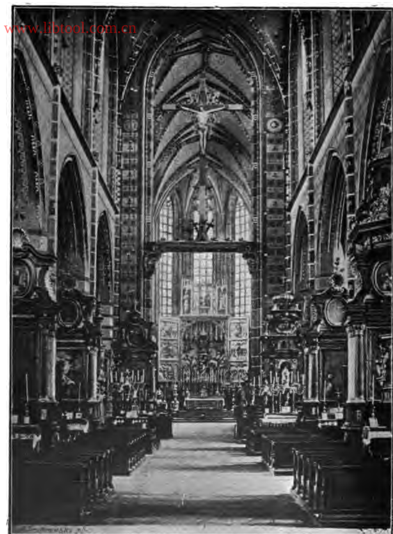
Wnętrze kościoła N. P. Maryi w Krakowie.
