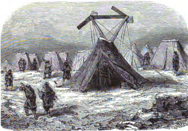
Fig. 67. — Installation d'un poste télégraphique à Kamiesch (Crimée).
