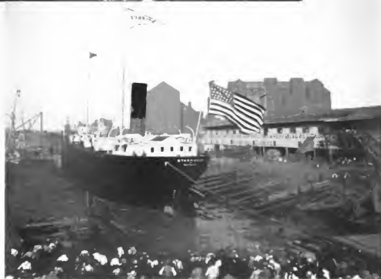
SHOWING S. S. STARRUCCA AFLOAT IN DRY DOCK.
