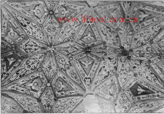
Abb. 3. Ehrengruben Gewölbemalerei von 1644.
