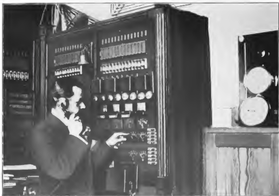
Das Prüfen der Leitungen einer elektrischen Normalzeit-Anlage
