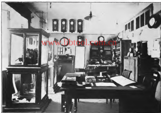
Anlage zum Betrieb zahlreicher elektrischer Normaluhren (Gesellschaft „Normalzeit“ in Berlin)
