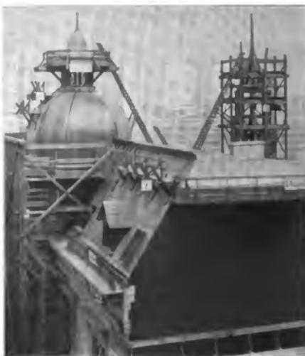
Abb. 4. Turmgerüst und Dachdeckerböcke.
