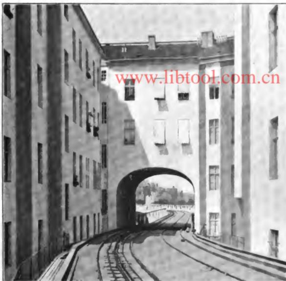
Abb. 4. Durchschlitung eines Hauses (Dennewitzstrasse).
