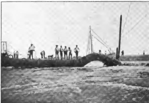
Abb. 1. Die Hebung der Stadt Galveston. Endpunkt eines Spülrohres von 1,10 m Durchm.
