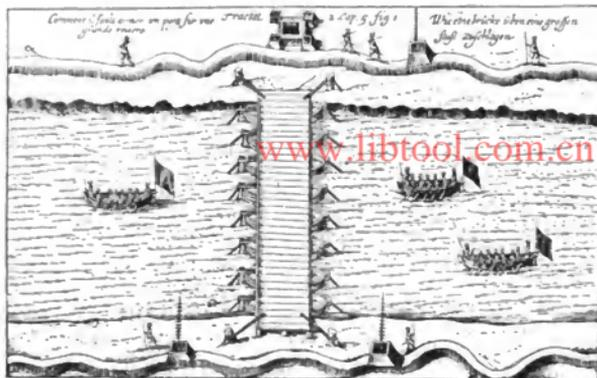
Abb. 2. Schiffsbrücke nach Diego Ufano, 1628.
