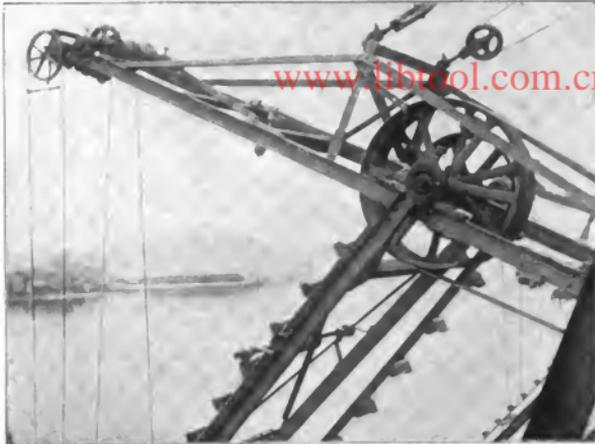
Abb. 13. Anhängung der Sandelevatoren nebst Umstellwinde und Ausrücker in Abbildung 12.
