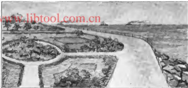
Abb. 4. Die Hebung der Stadt Galveston. Fertige Sandschüttung hinter dem Betonwall.
