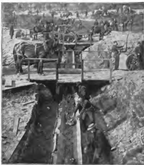
Abb. 11. Erdschubtransporte beim Bau einer Gasanstalt.
