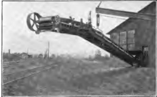
Abb. 16. Fahrbarer Gurtförderer für Eisenbahnwagenbeladung.
