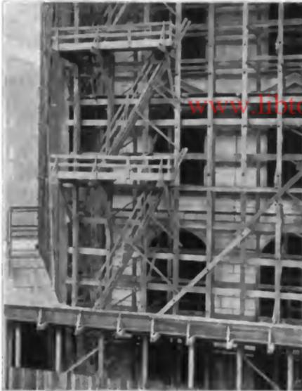
Abb. 2. Versetz- und Fahrgerüst.
