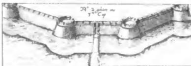
Abb. 2. Ringmauer mit niedriger werdenden, halbkugelförmig vorspringenden Türmen, nach Lorini.
