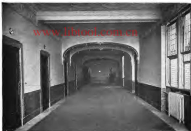
Glühlampen-Anlage mit Bedienungslampen über der Zimmertür; die Gruppenlampe im Hintergrunde.
