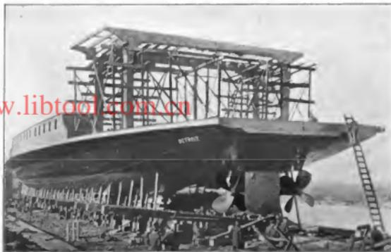
Abb. 4. Unterransicht der Eisenbahnfähre »Detroit« während des Baues.
