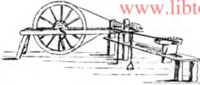
Abb. 3. Drehbank mit Kurbelantrieb.
