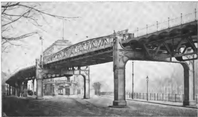
Abb. 8. Pendelstützen am Sedanufer bei aussergewöhnlicher Stützenbreite.
