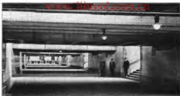
Abb. 2. Bahndurchführung mit Spar-Bogenlampen-Beleuchtung.
