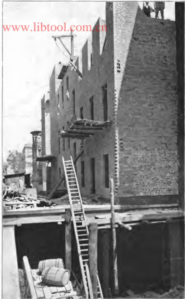
Abb. 3. Untertunnelung von Gebäuden der Köthener Strasse.
