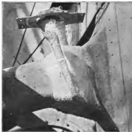
Abb. 1. Ausgeführte Schweißung mit Einlauf- und Steigetrichter und Überlauf an der Wellenbose des Dampfers »Friedrich der Grosse«.
