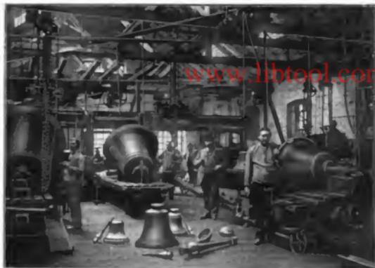
Abb. 4. Die Bearbeitung der Glockenkronen.
