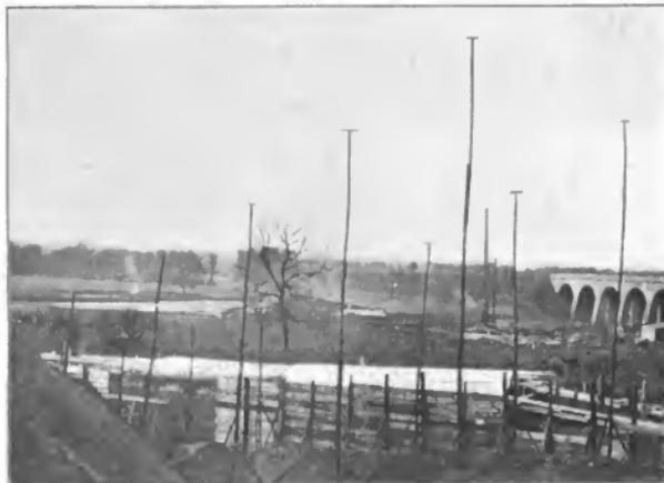
Abb. 3. Rennbahn Weybridge-Brooklands. Die Höhenverhältnisse in den Kurven sind durch Stangen markiert.
