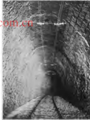
Abb. 5. Aufhängung der Kontaktleitung im Tunnel.
