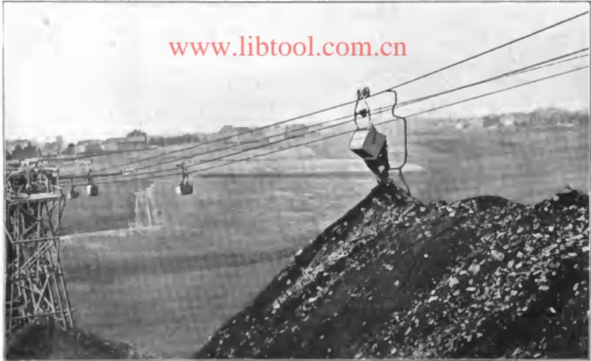
Abb. 7. Selbsttätige Entleerung des Drahtseilwagens während der Fahrt.
