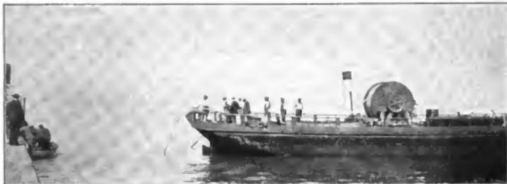
Abb. 6. Die Verlegung des Uferkabels bei Romanshorn.
