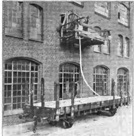
Abb. 2. Einlegung des Kabels aus der Fabrik in die Eisenbahnwaggons.
