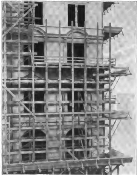
Abb. 3. Versetz- und Fahrgerüst.
