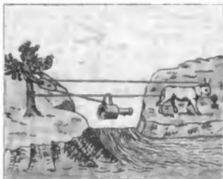
Abb. 2. Transport eines Geschützrohres über einen Fluss. Nach Jacopo Marisno. 1438.
