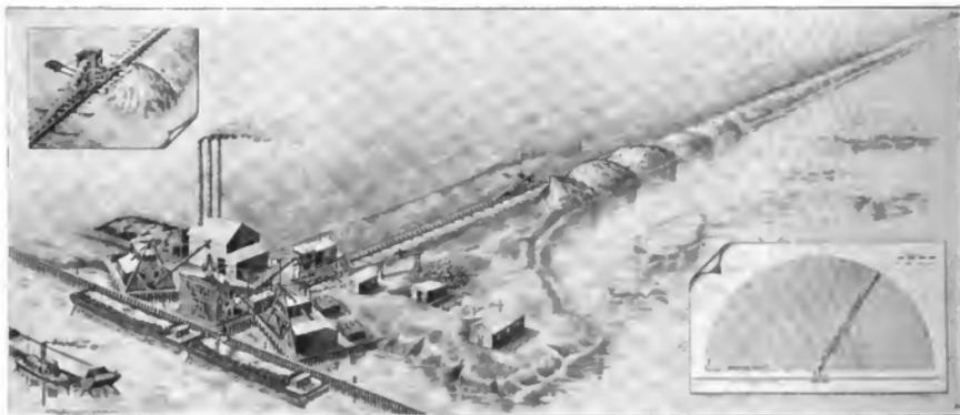
Abb. 15. 300 m lange drehbare Robins-Gurtförderer zum Transport von Schutt.
