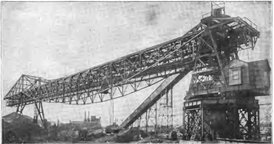
Verladebrücke für Kohlen, stündliche Leistung 600 t. (Die Brücke ist um die Antriebsstation drehbar.)
