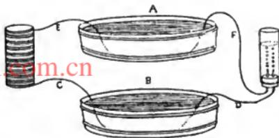
Abb. 3. Schillings Vorschlag zur Verbesserung des Soemmeringschen Telegraphen.
