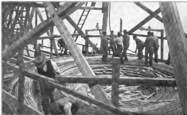
Abb. 3. Unterbringung des Kabelringes auf dem Verlegenschiff.
