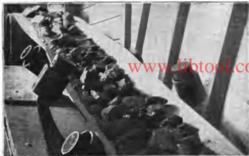
Abb 10. Robins Gurtförderer, unter 16\* Ersatzstärke nach oben förderend.
