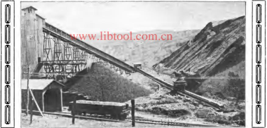
Beweglicher Förderer beim Bergbaubetriebe in Verbindung mit einer Dampfschaufel.
