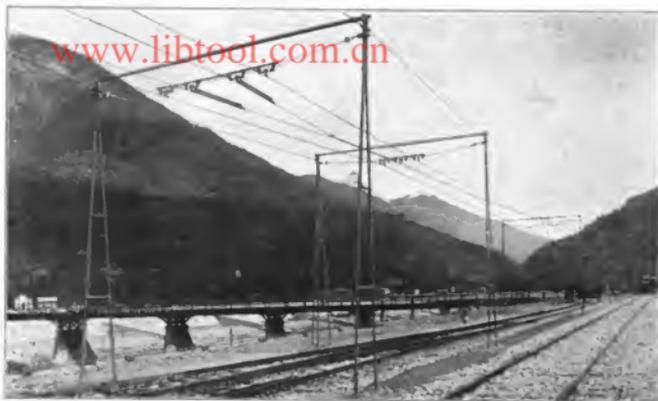
Abb. 7. Anordnung einer kompletten Luftweiche.
