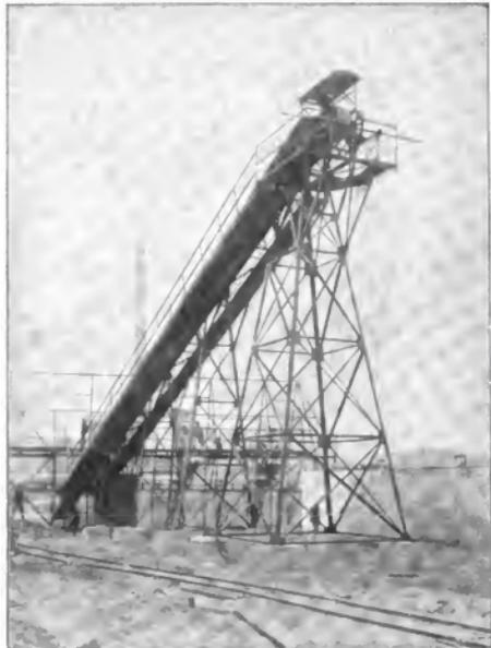
Abb. 14. Gurtförderer für die Aufstapelung des Sandes auf den Lagerplatz. Steigung des Förderers 22°. Leistung 50 cbm in der Stunde.
