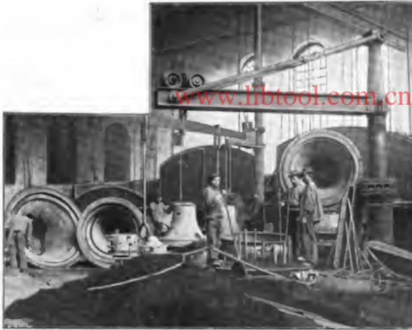
Abb. 2. Die Herstellung der Formen für die Gussstahlglocken.
