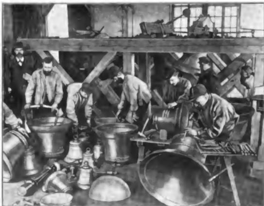
Abb. 5. Das Verputzen und Ziselieren der Glocken.
