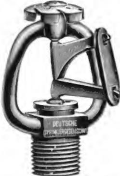
Abb. 3. Löschbrause, System International (geschlossen).
