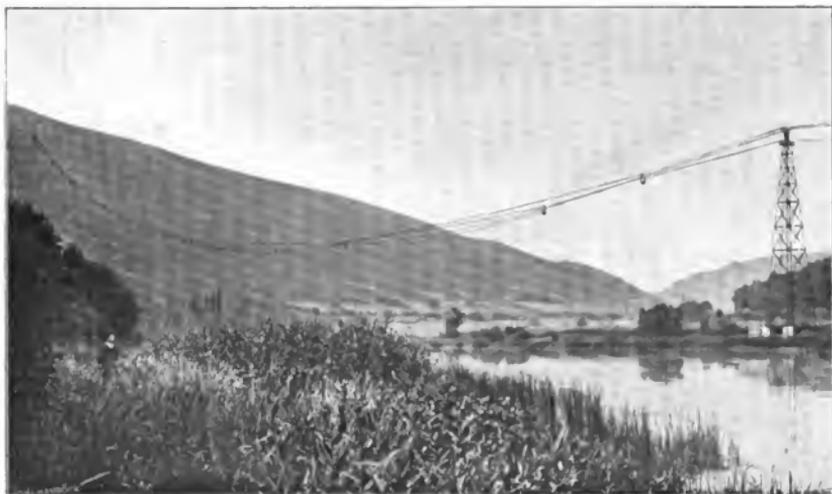
Abb. 1. Spannweite von 800 Metern an der Drahtseilbahn des Tonwerks Friedrichsagen, Friedrichsagen a. d. Lahn.
