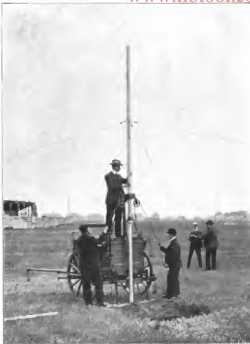
Abb. 1. Aufrichten des Mastes mittels der Aufrichtevorrichtung.
