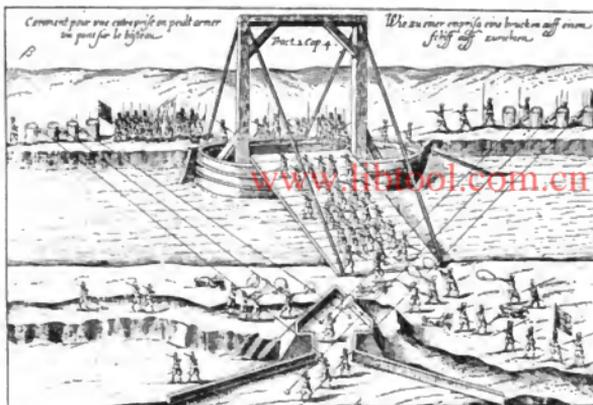
Abb. 5. Schiff mit Fallbrücke nach Diego Ufano, 1628.
