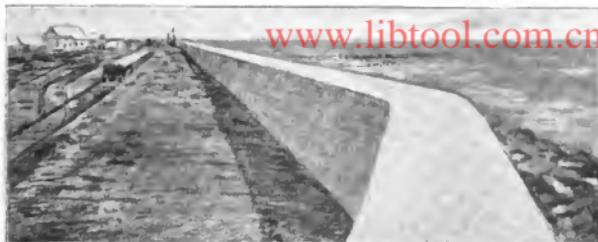
Abb. 3. Die Hebung der Stadt Galveston. Ein Teil des Betonwalles während des Baues.
