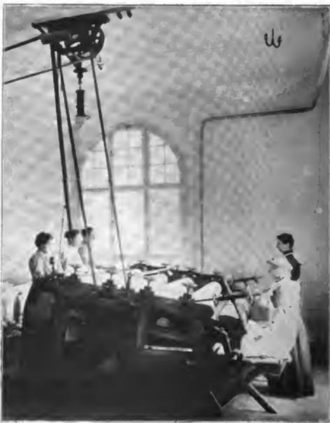
Abb. 1. Spar-Bogenlampen-Beleuchtung in einer Wäscherei.
