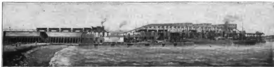
Abb. 1. Schiffabkohlungs-Anlage für 500 t stündliche Leistung.
