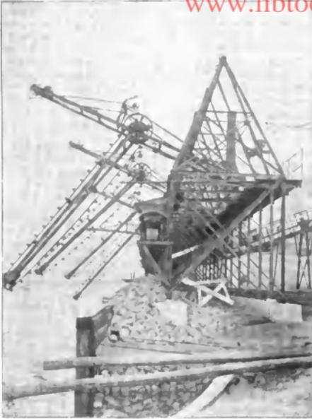
Abb. 12. Schiffslade-Anlage eines Mortelwerkes.
