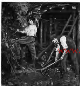
1. Abbaubetrieb in der Steinkohle mit Meißel, Fäustel und Keilhaue.
