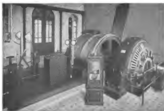
4. Elektrische Fördermaschine, System Ilgner-Siemens &amp; Halske.
