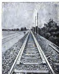
3. Gleis mit Leitschielen der elektrischen Schnellbahn.
