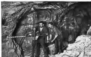
3. Handbohrmaschine (Salzwerk Leopoldshall).
