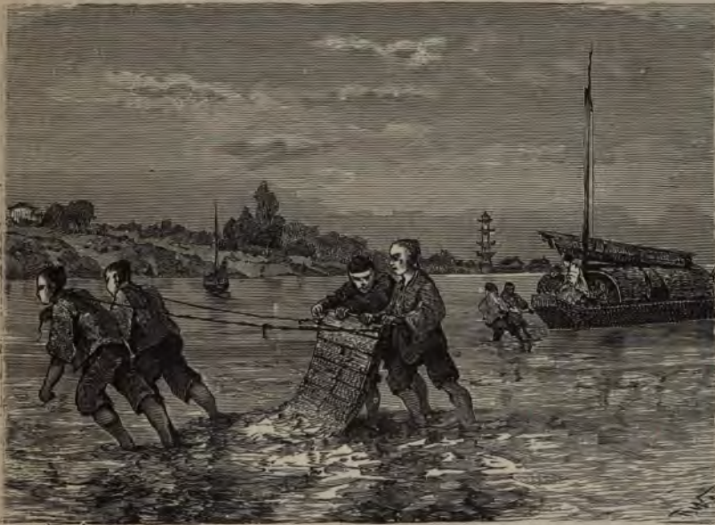
Ausbaggern des Flusses.
