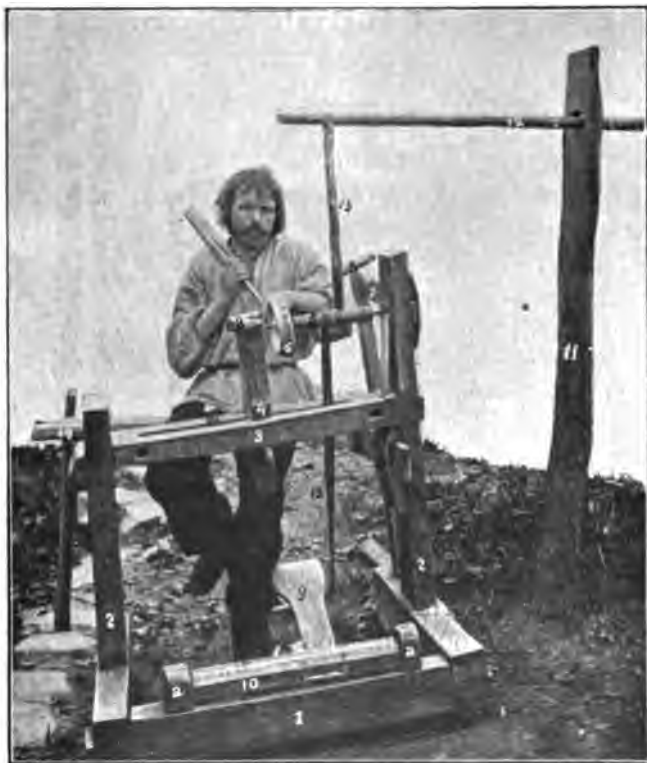
223. Wasył Szkryblak przy tokarni. 1. Podstawa; 2. 2 słupy; 3. ogniwo — ohnywo ; 4. zajac ; 5. wałek; 6. materiał przeznaczony do toczenia; 7. re-szitec ; 8. krywila ; 9. postil ; 10. worotylo — obracające się w żabkach (a. a.); 11. słup; 12. żerdź; 13. rzemień; 14. siadka.
