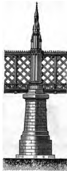
Élévation latérale d'une pile en rivière.
