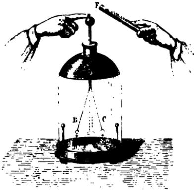
par lesquelles Bonnet remplaça ces divers systèmes, et l'on aura la description complète des électromètres à fils, à boules, à pailles et à lames d'or que les électriciens ont tour à tour construits. On n'emploie plus aujourd'hui que le dernier, et, pour lui donner le degré d'exactitude dont il est susceptible, il ne reste plus qu'à vernir à la gomme laque le haut de la cloche, à sécher l'intérieur avec de la chaux vive qu'on y laisse
