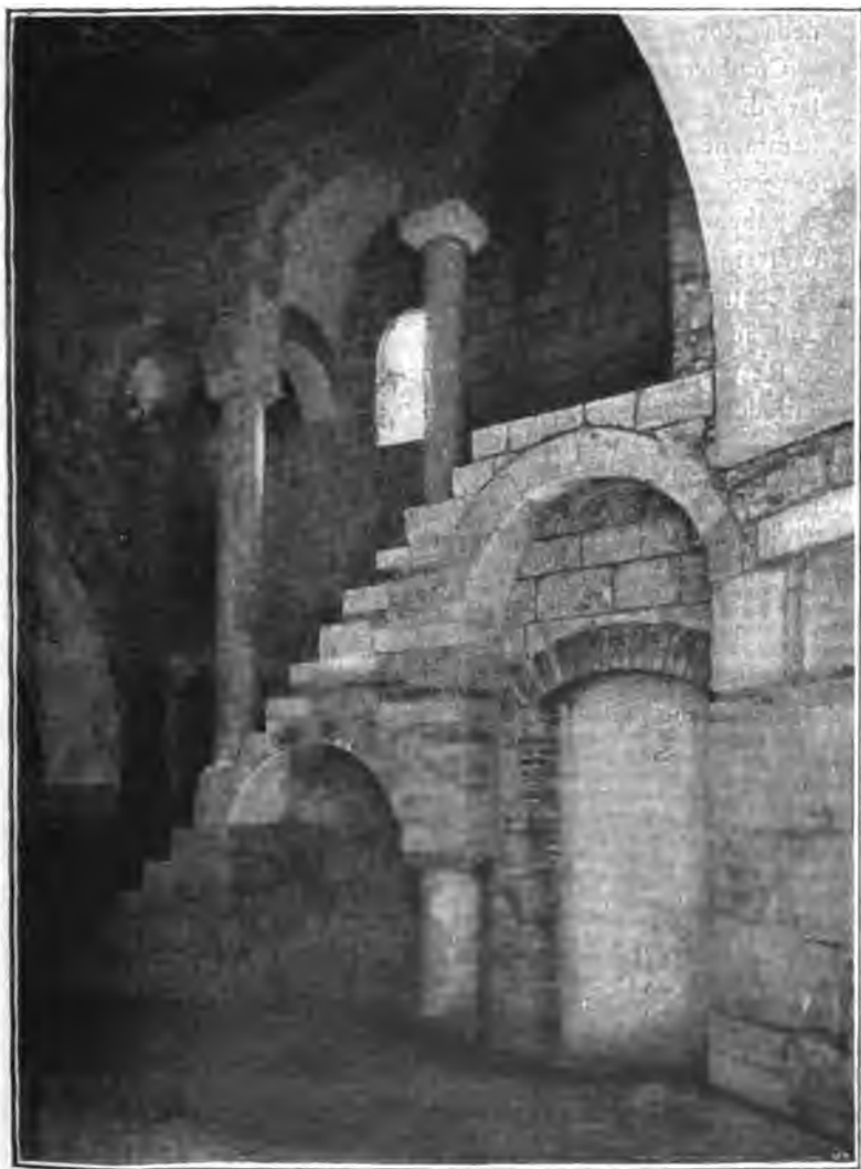
SCALA CHE DAVA ACCESSO ALLA TORRE (a destra della porta attuale).
