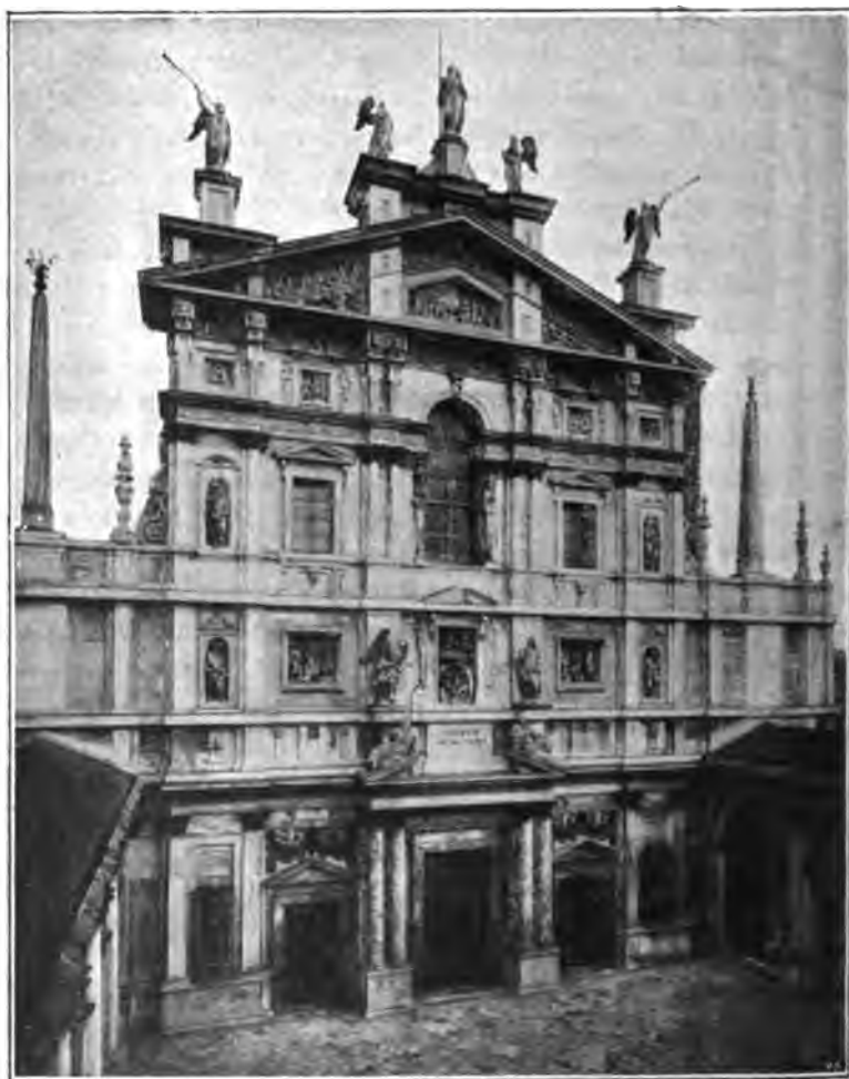
SANTA MARIA PRESSO S. CELSO — FACCIATA DOPO IL RESTAURO.
