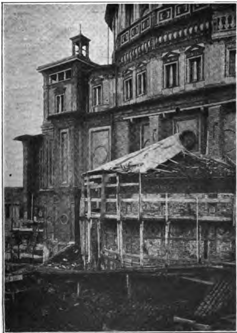
CAMPANILE RESTAURATO ED ABSIDE IN CORSO DI RESTAURO.
