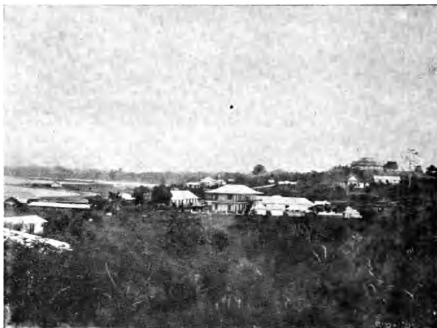
Fig. 2 — Praia vista de Oeste
