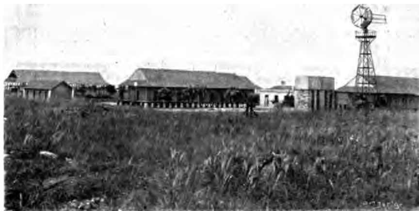
Fig. 4.— Hospital visto de sueste
