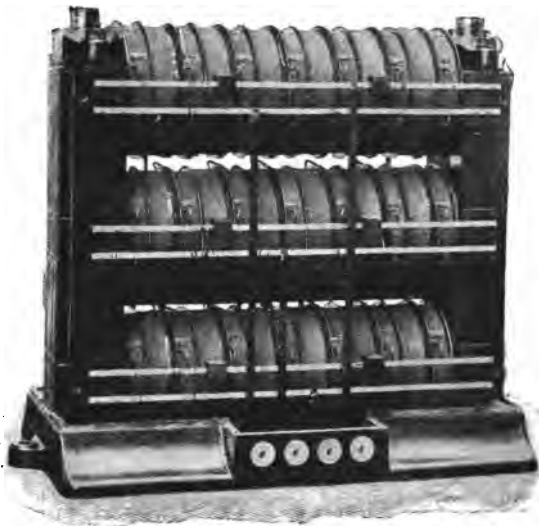
Fig. 267. Drehstromtransformator ohne Schutzkappe.
