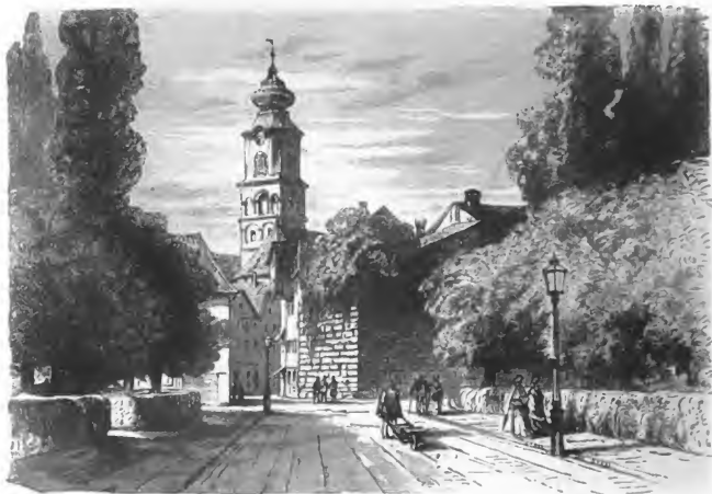
Heidenmauer in Lindau.
